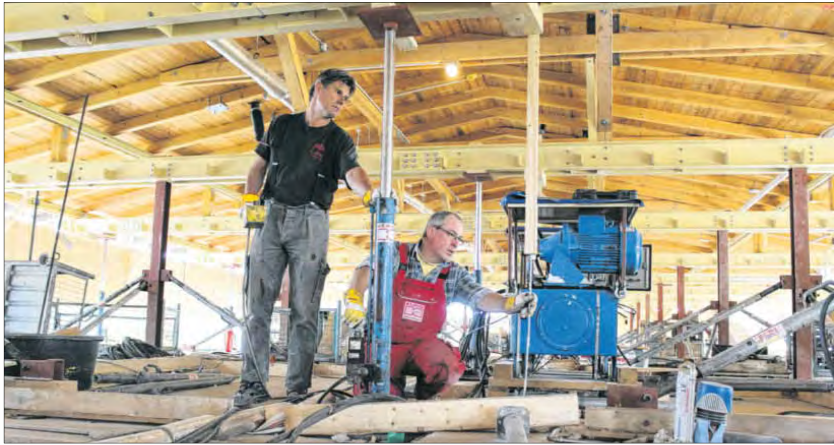
In vier Etappen hoben die Spezialisten aus Augsburg das Dach des Ostflügels gestern um insgesamt 80 Zentimeter an. Das Bild zeigt Franz Ullmann (l.) und seinen Kollegen Arthur Deurer beim Nachjustieren der Hydraulikzylinder.
