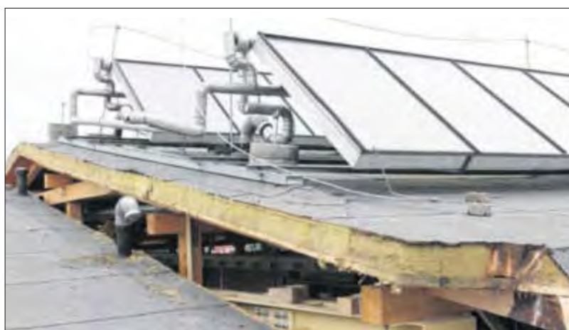
Der erste Schritt ist getan. Bis Freitag soll das Dach auf dem Ostflügel um insgesamt etwa zwei Meter angehoben werden.
